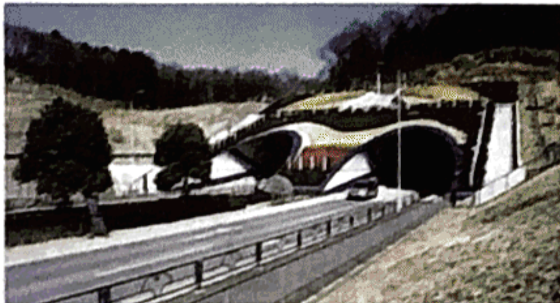
小山内裏トンネル
